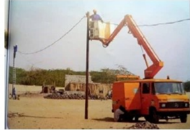
الصورة (14): عمال الكهرباء في أثناء الربط.
